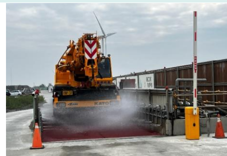
出入口設置 洗車設備
