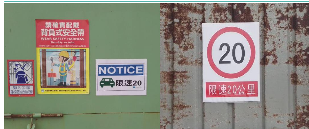
工區前設置適當標誌， 預警車道縮減、禁止變換車道或減速
