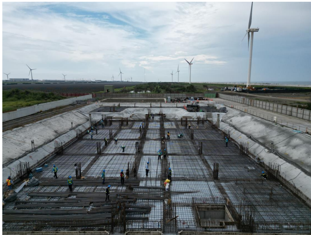
本計畫陸域施工現況圖
