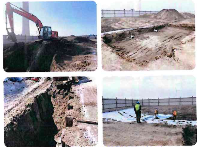
114.01地下管排開挖監看情形
