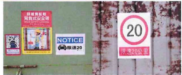
工區前設置適當標誌，預警車道縮減、禁止變換車道或減速
