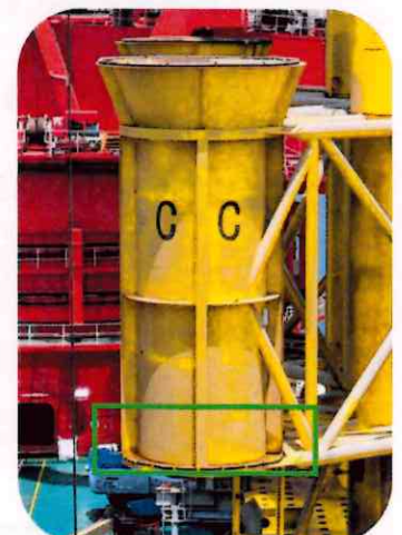
打樁模架下層新增氣泡幕
