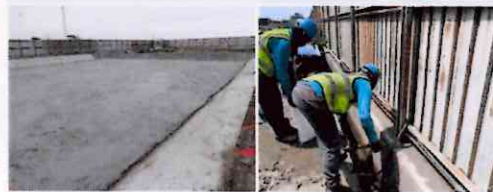
營建工地開挖面或堆置場所之擋雨、遮雨、導雨、沉砂池設施及其定期清理維護工作
