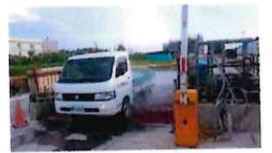
出入口設置洗車設備
