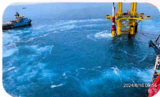
氣泡帷幕佈放情形
