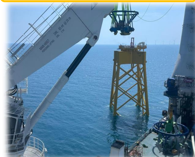
風機下部結構（套筒桁架安裝）
